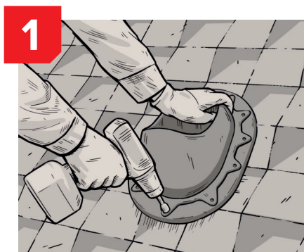
1 Вентиляционный выход устанавливается на заранее смонтированный проходной элемент.
