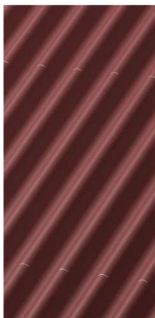
Нанесёнными метками под гвозди (шаг 61 см)
