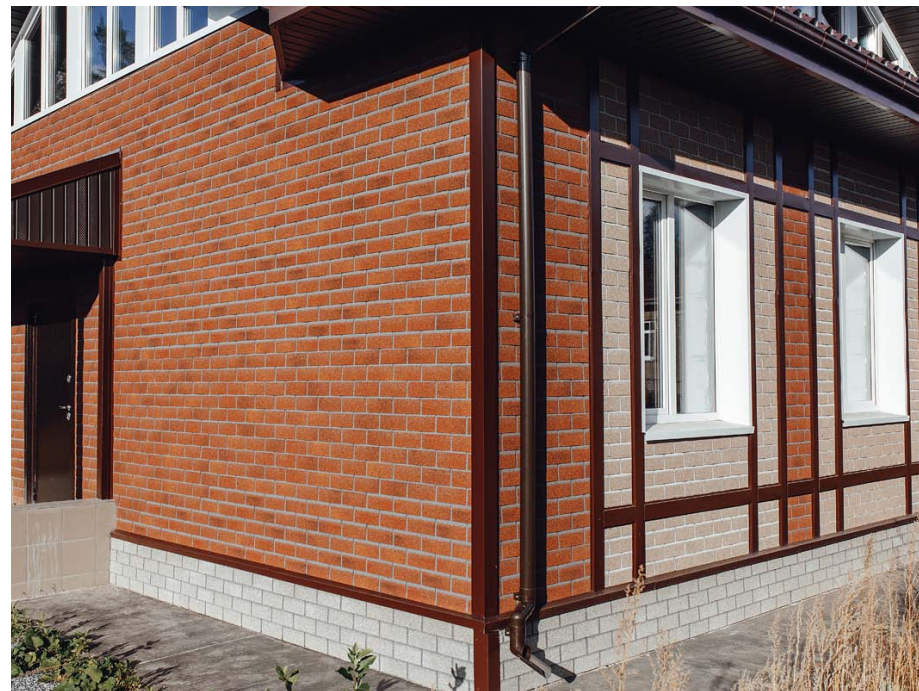
Рис. 1. Оформление фасада и цоколя
